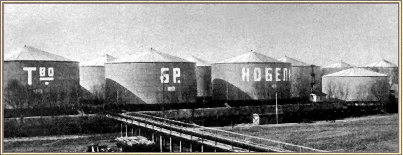
Həştərxanda "Nobel Qardaşları" şirkətinə məxsus rezervuarlar
